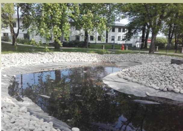
Arbete med dagvattendamm i Stadsparken, Västervik.
