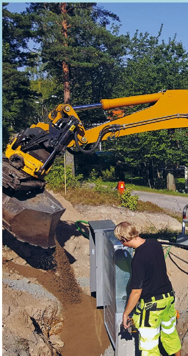
Installationsarbete för fiberanslutning av en fastighet.
