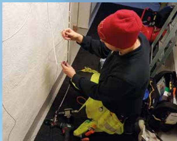
Installationsarbete på plats hos en företagskund.
