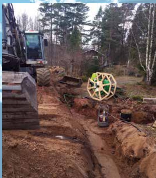
Utbyggnad på Tättö - samförläggning med vatten och avlopp.
