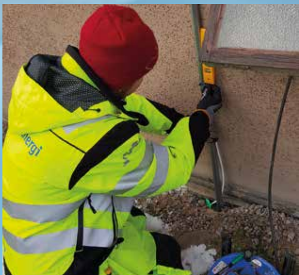
Installationsarbete för fiberanslutning av en fastighet.
