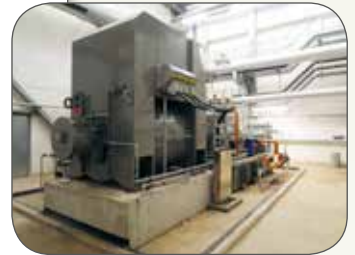
I turbinen omvandlas mekanisk energi till elektricitet.
