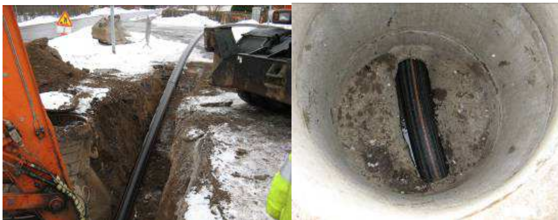
Renovering av dagvattensystem med relingsteknik.
