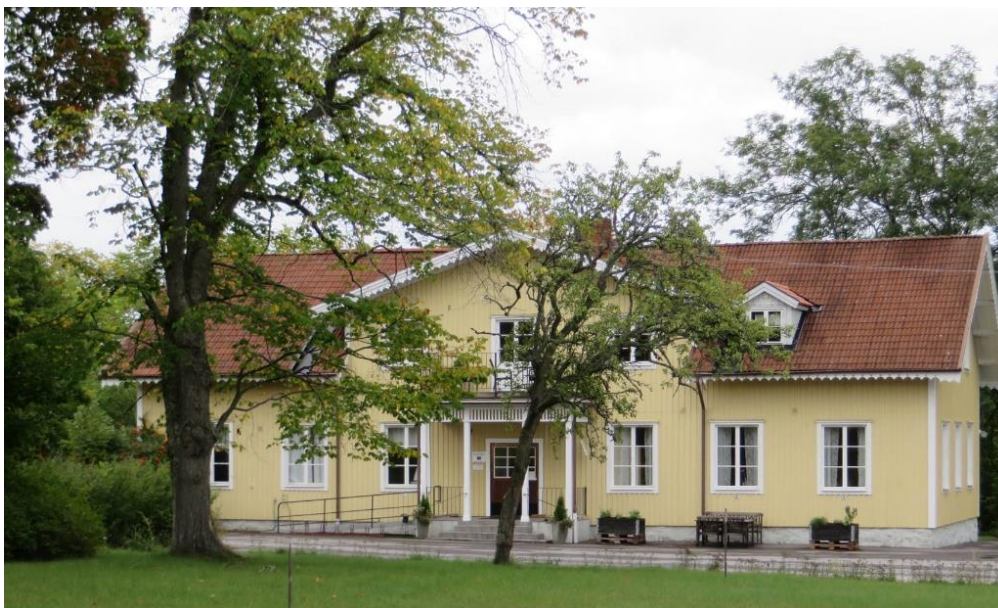
Figur 4. Befintlig huvudbyggnad, vy från väster.
