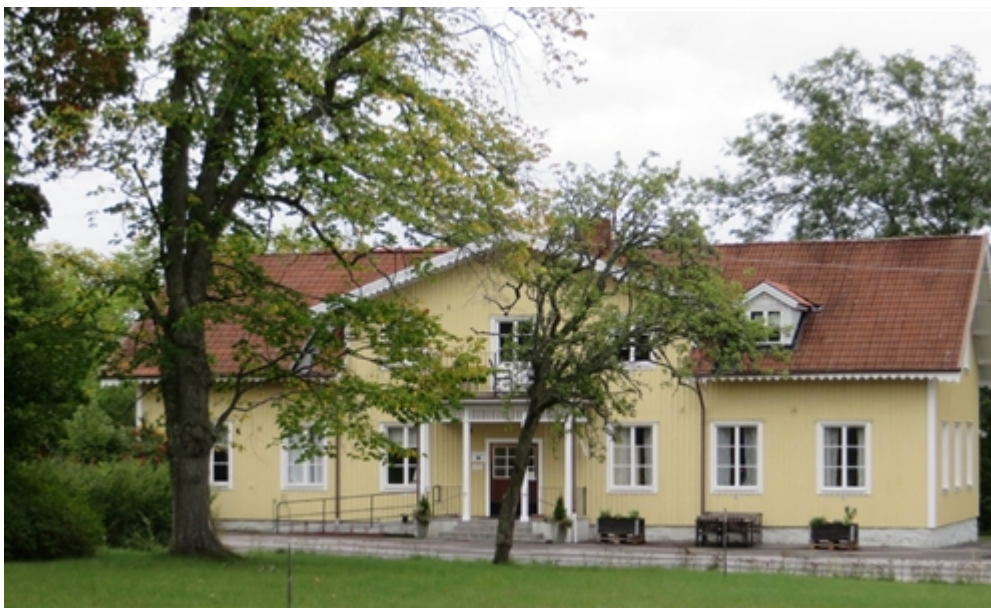
Figur 4. Befintlig huvudbyggnad, vy från väster.
