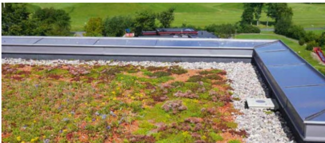
Figur 10. Exempel på sedum-örttak med 500 mm singelremsa mot taksarg (Svensk Byggtjänst, 2021)
