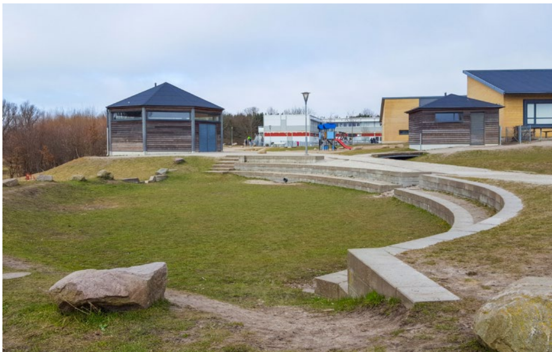
Figur 18. Multifunktionell yta för utjämning av dagvatten och skyfall -utgör lekyta under merparten av året (Häminge kommun, 2017).
