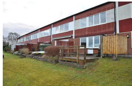
Bild 1 Väggar och utgångar till stor del av fönster.
