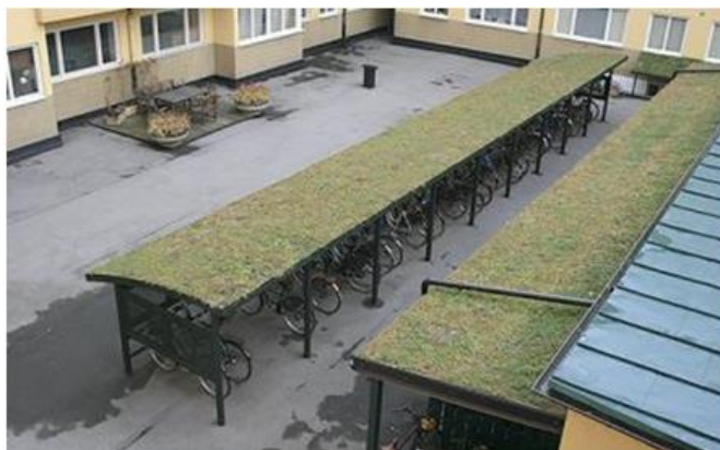
Figur 12: Grön takbeläggning på cykelställ. Källa: Welandutemiljö.se (2012).
