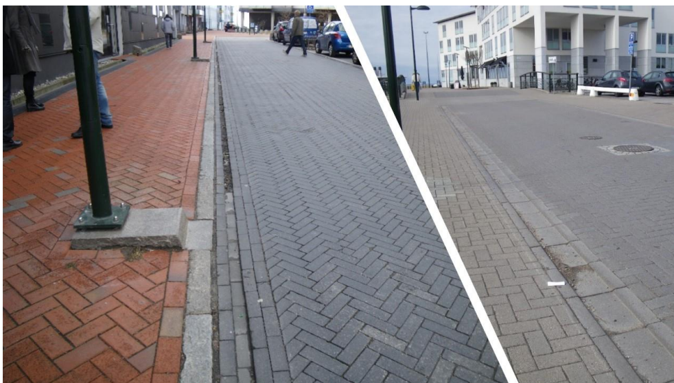
Figur 8: Exempel på öppna dagvattenrännor (Sweco, 2019).
