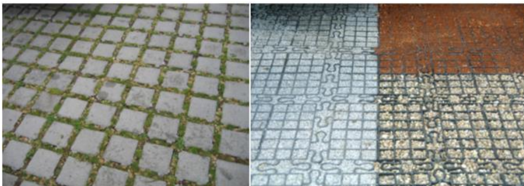
Figur 13: Genomsläppliga beläggningar. (Sweco, 2010).
