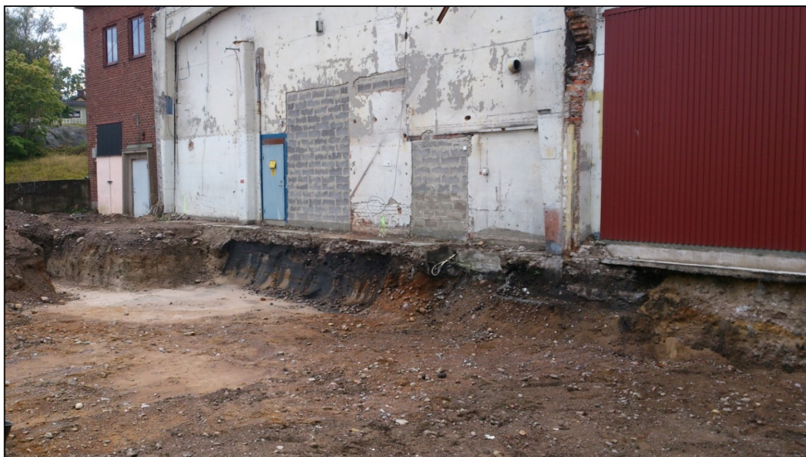
Mörk påverkad jord under kvarvarande byggnadens sydostligaste hörn. Foto: Västerviks kommun 2016
