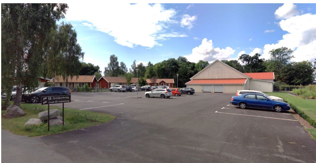
Området sett från Gränsövägen, Magasinet till höger, hotellbyggnaderna till vänster.
