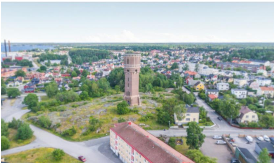
Figur 30: Drönbild på Gamla vattentornet.
