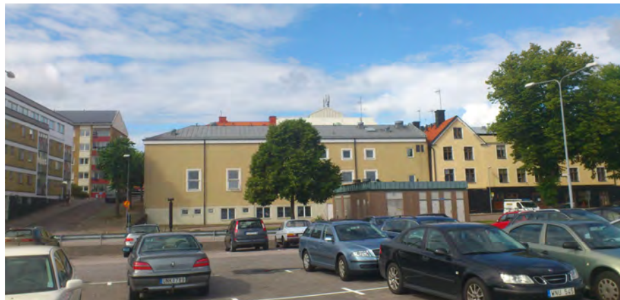
Byggnaden på Långholmen 3 sett från Skeppsbrokajen. Långholmen 1 till höger i bild.
