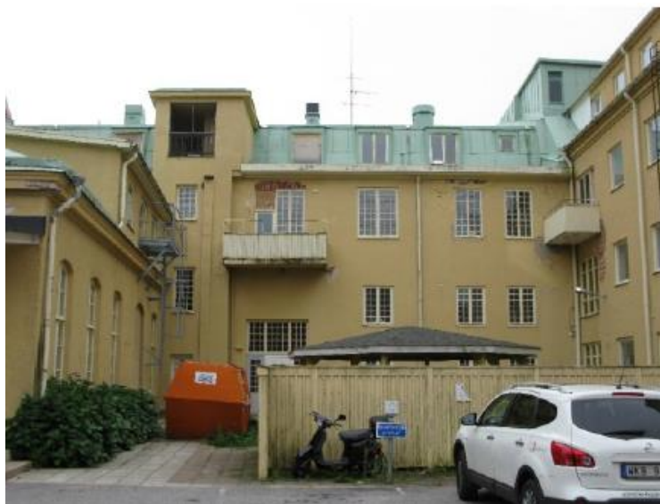
Bild: Fasad av elektricitetverksbyggnaden sett från gården.
