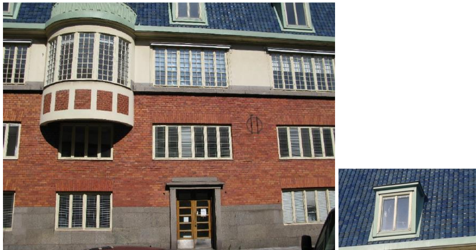
Bild: Fasad av Elektricitetverksbyggnaden sett från Kvarngatan.
