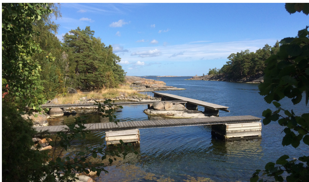
Befintlig brygganläggning vid fastigheten Horn 1:5 i Spårösund som möjliggör angöring för skärgårdstrafiken från Västervik
