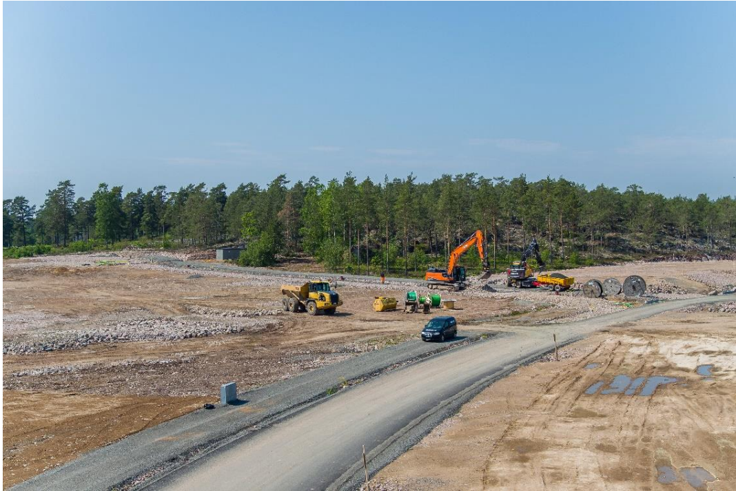
FIGUR 10: Grundarbeten pågår i och omkring planområdet 2019-06-05. Källa Kannonaden
