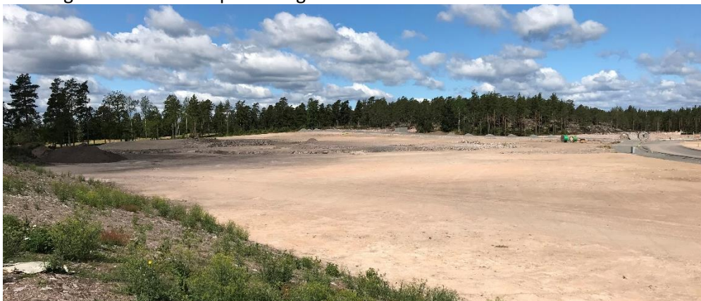
FIGUR 9: Grundarbeten utförda inom planområdet.
