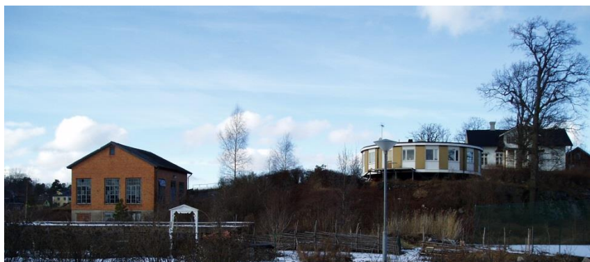
Till vänster syns turbinhallen som tillhört sågverket. På kullen till höger är ”runda huset” och bakom det syns disponentbostaden.
