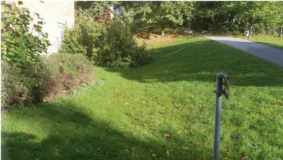
Figur 17. Nedsänkt dräneringsstråk mellan hus och gc-bana ( Tyréns AB , 2020)
