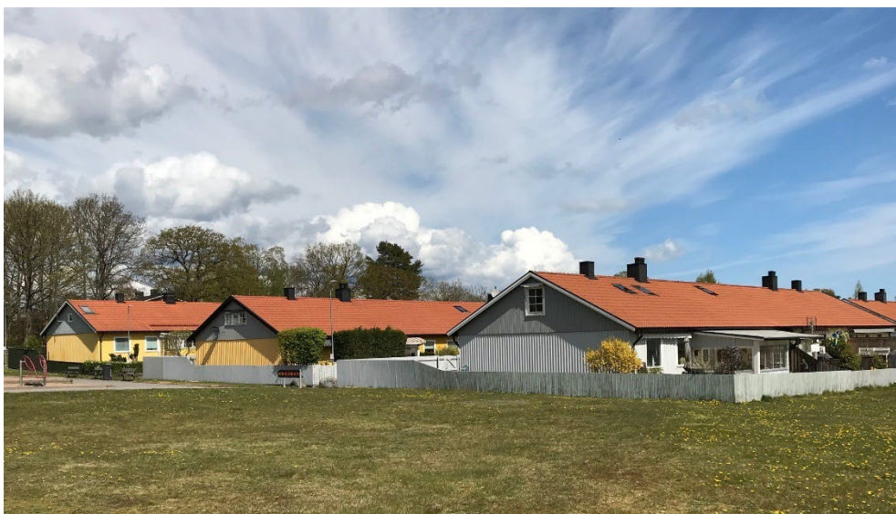
FIGUR 12: Befintlig radhusbebyggelse sedd från väster
