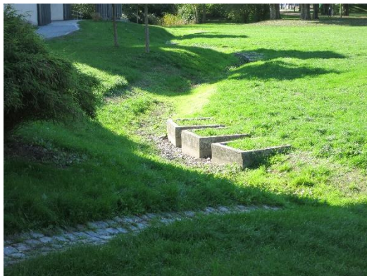
Figur 29. T.v. exempelbild på ett avskärande dike med viss utjämningsvolym. T.h. Exempelbild på bräddkupol (Foto: Tyréns)
