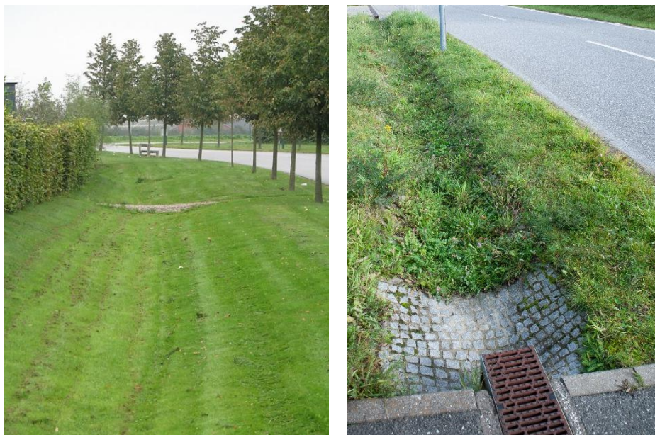
Figur 22. Exempelbilder på svackdiken (Foto: Tyréns)
