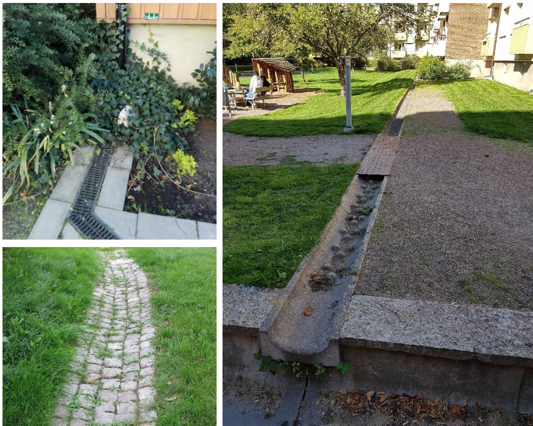
Figur 27. Exempelbilder på olika typer av rännor för ytlig avledning av takvatten (Foto: Tyréns)
