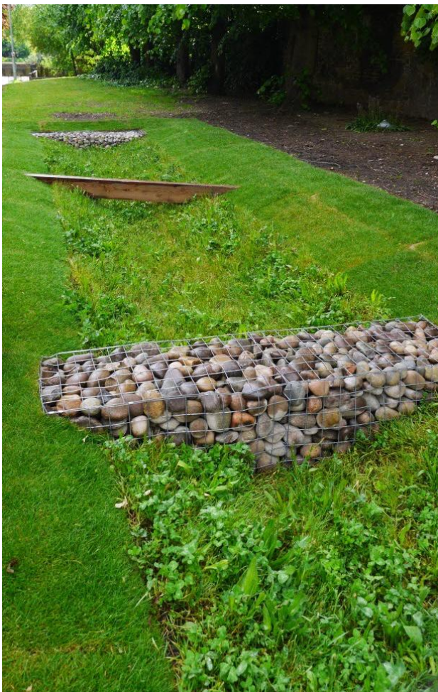
Figur 31. Exempelbild på ett trappat dike som fördröjer och utjämnar dagvatten, t.ex. vid skyfall (Foto: Boverket, 2020)
