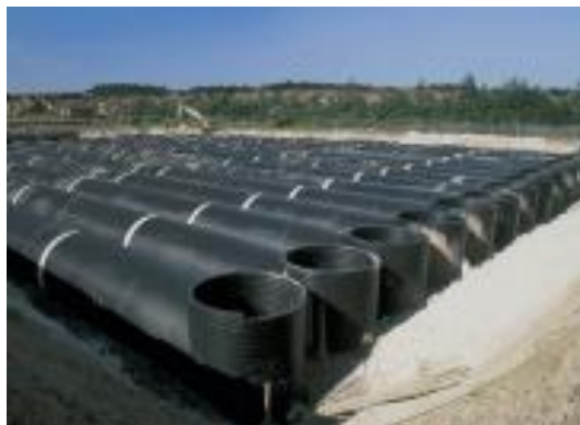
Figur 28. Exempel på större rörmagasin, samt typritning från Uponor (Foto: Stockholm Vatten och avfall, ritning från Uponor).
