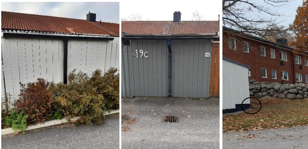
Figur 2. Exempel på avvattning av takytor för komplementbyggnader och garage inom kvarteret Topasen 2. Utkastare från garagetak är markerad i svart. (Foto: VME)
