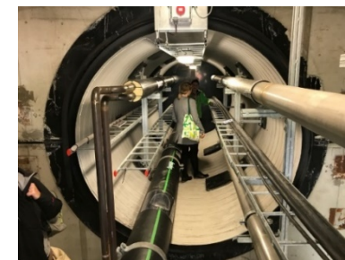
Kulvert för teknisk infrastruktur, Vallastaden Linköping (foto: Marcus Åberg)
