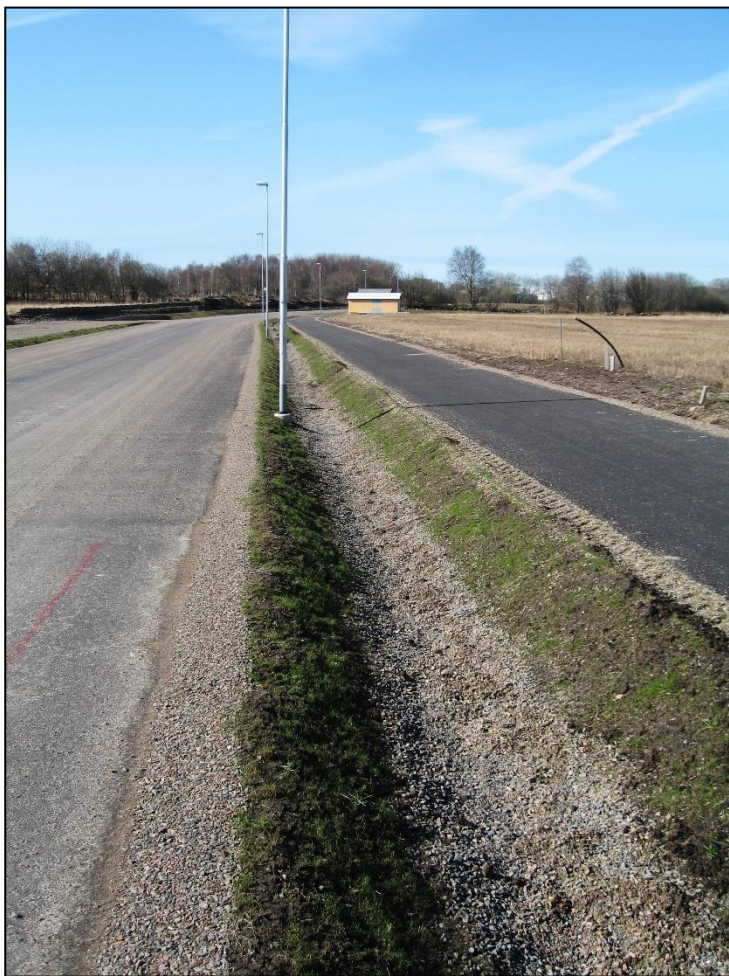
Figur 14, Exempel på hur makadamdiken används mellan väg och cykelväg (Foto: Norconsult)
