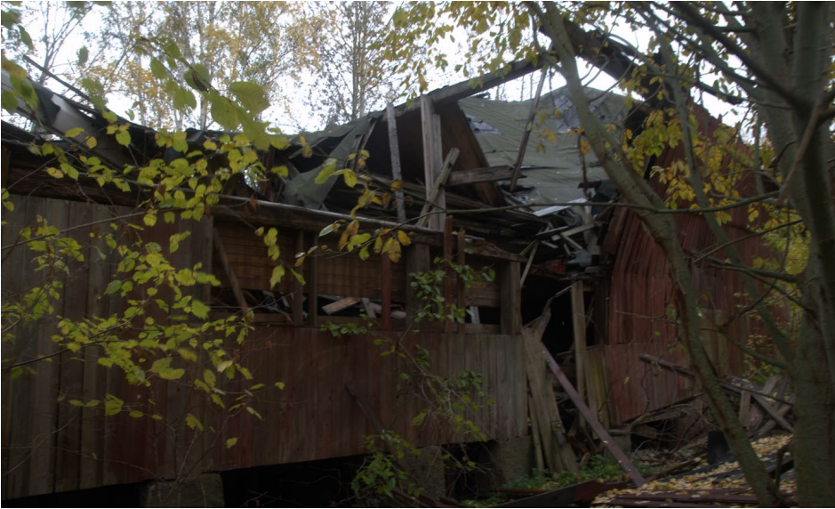
Figur 17 Vy från norr. Magasinets västra del. Datum: 2023-10-25.
