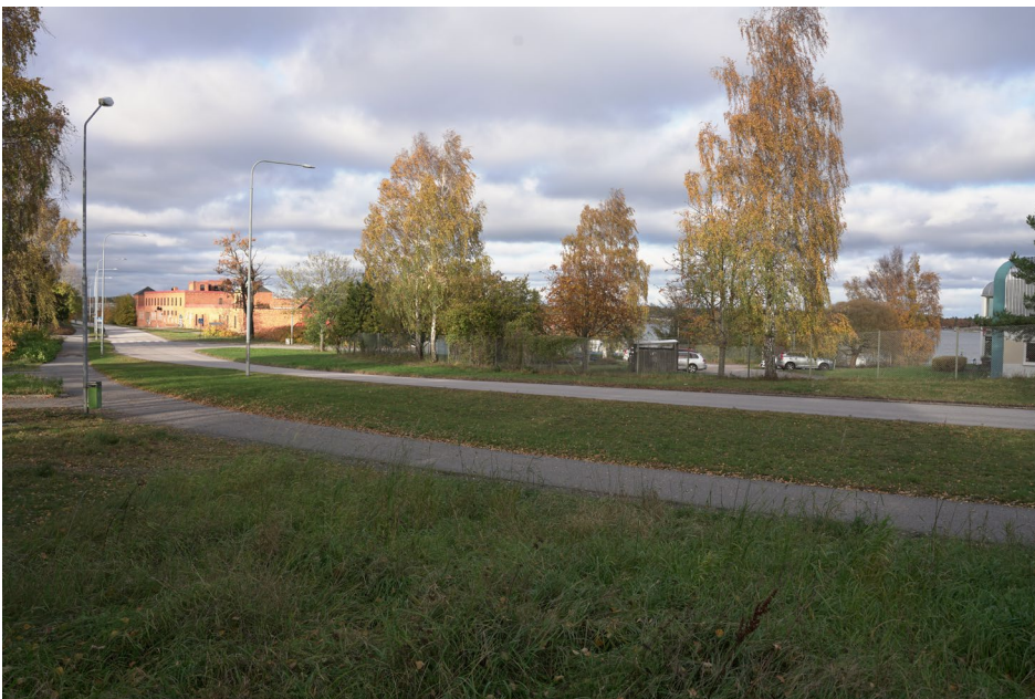
Figur 22 Vy från sydväst längs med Lucernavägen. Här ser man den nära kopplingen mellan vattenrummet och industrin. Datum: 2023-10-25.
