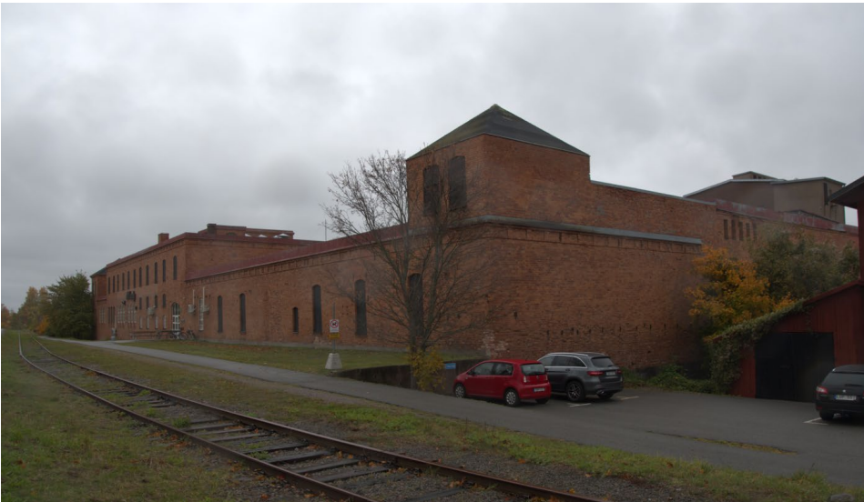
Figur 10 Vy från söder över den stora tegelbyggnaden som är före detta Tanninfabriken, i förgrunden ser man järnvägens hamnspår. Datum: 2023-10-25.
