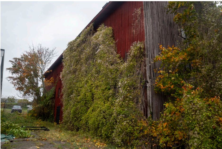
Figur 15 Vy från öst. Magasinet's södra fasad är täckt med vegetation. Datum: 2023-10-25.
