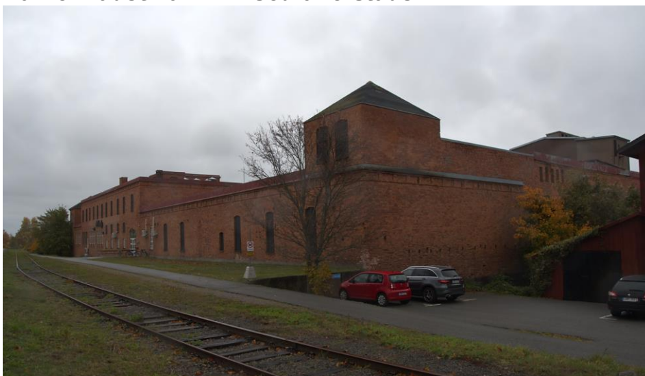
Figur 9 Vy från syd över den stora tegelbyggnaden som är före detta Tanninfabriken, i förgrunden ser man järnvägens hamnspår. Datum: 2023-10-25.
