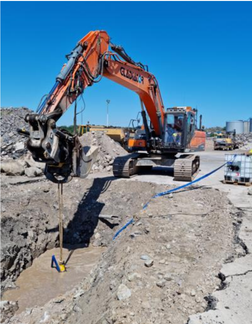
Figur 1. Pumpning av vatten vid provpunkt 22SW02GW, 2023-06-28. Bildkälla Sweco Sverige AB. Totalt skickades 11,5 m 3 vatten till Fortum Waste Solution AB, Kumla.
