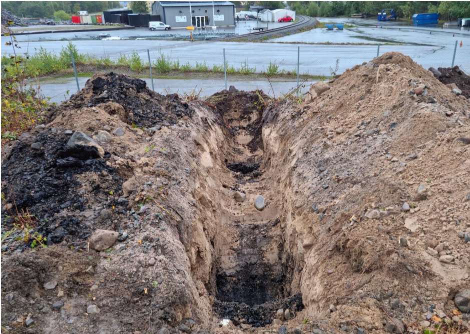
Figur 5. Grävt provtagningsdike för provpunkterna EBH2341:1 och EBH2341:2 Bildkälla Sweco Sverige AB 2023
