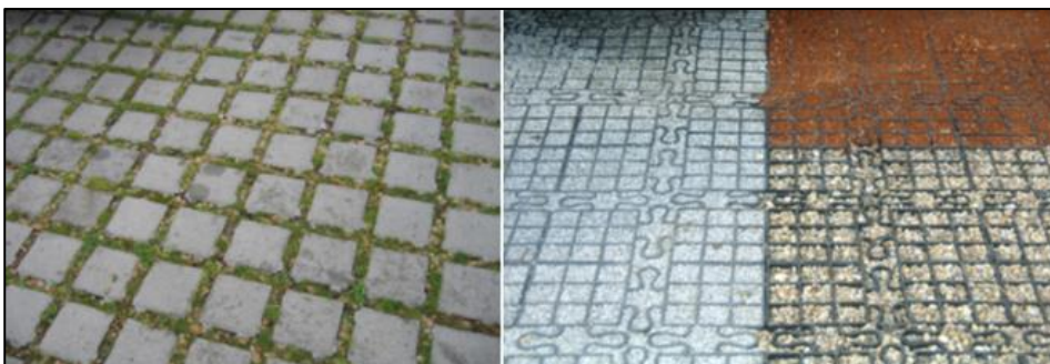
Figur 19: Genomsläppliga beläggningar. Bildkälla: Sweco
