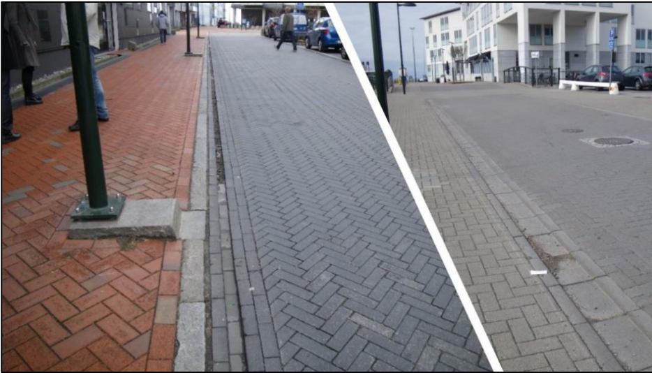
Figur 16: Exempel på öppna dagvattenrännor. Bildkälla: Sweco.
