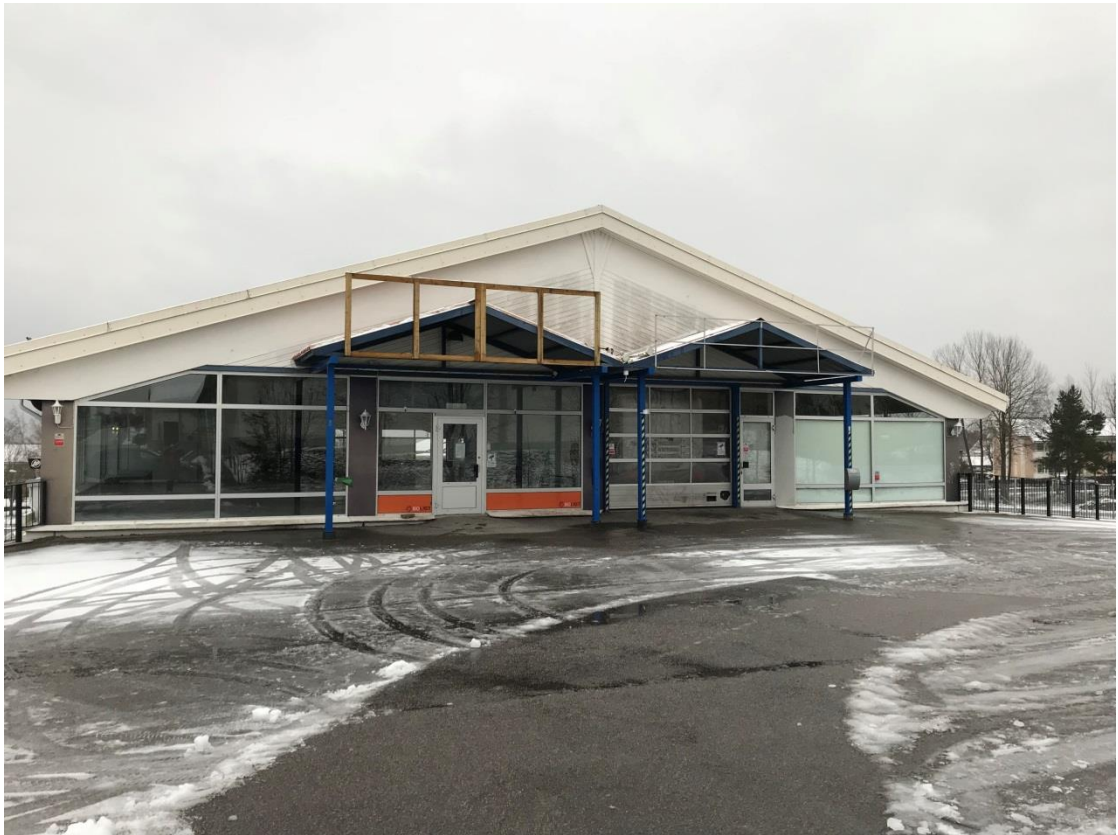
Tidigare entre till handelsverksamhet.
