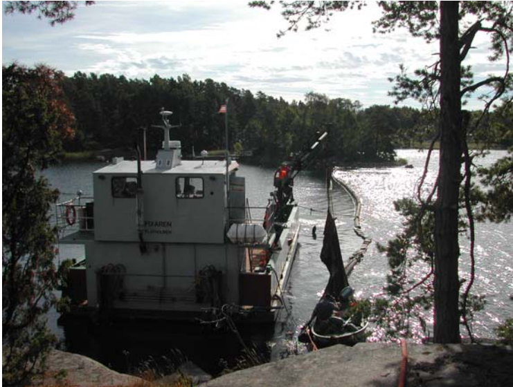
En geotextilduk läggs ut i mynningen till Örserumsviken för att förhindra grumling utanför arbetsområdet.
