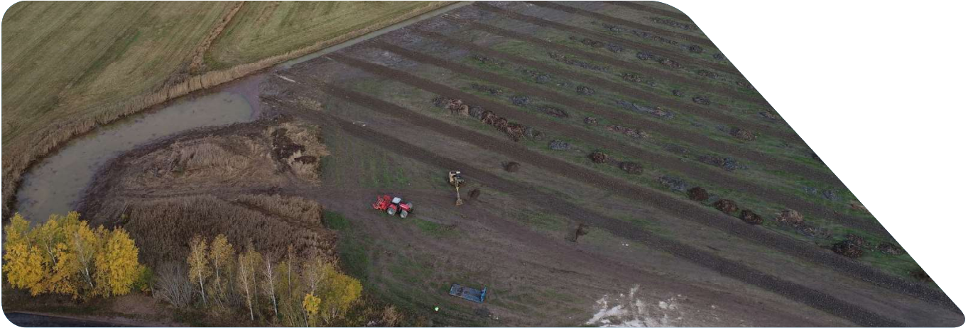
Anläggande av kalkfilterdiken och minivåtmarker i anslutning till Loftaån
