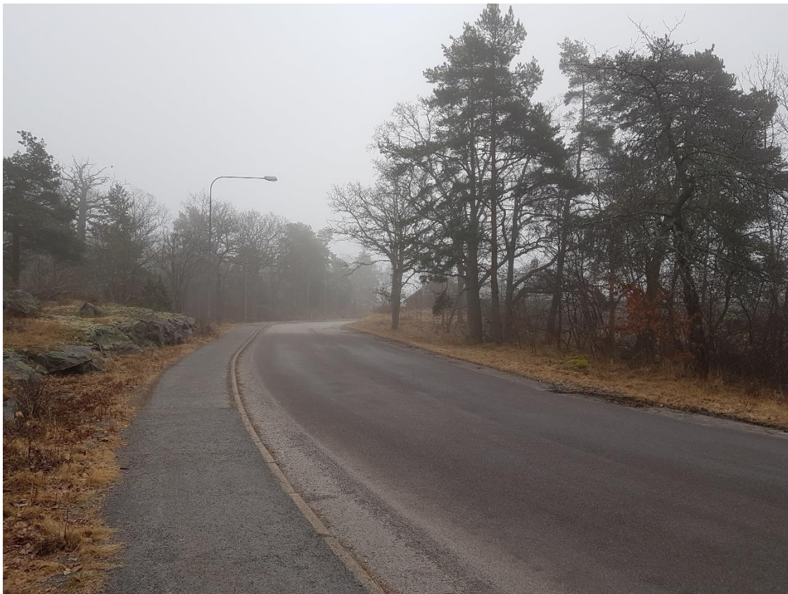
Figur 2. Bild tagen på Tändsticksvägen, ritning mot sydost. Foto: Tyréns AB.
