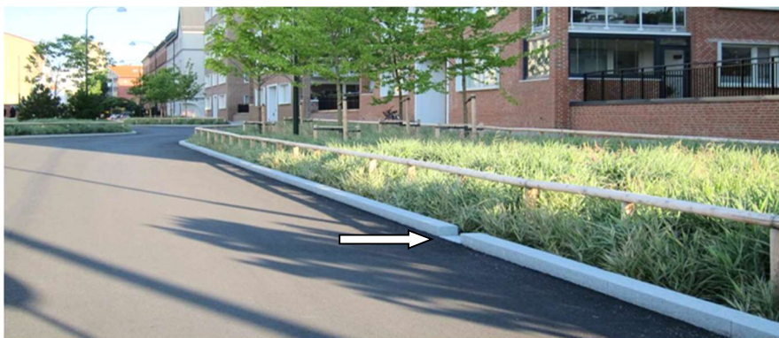
Figur 25: Principbild på regnbädd, från Monbijougatan i Malmö. Tillfälliga nedsänkningar i kantstenen (se pilen) fungerar som inlopp där dagvatten tar sig in i regnbädden.
