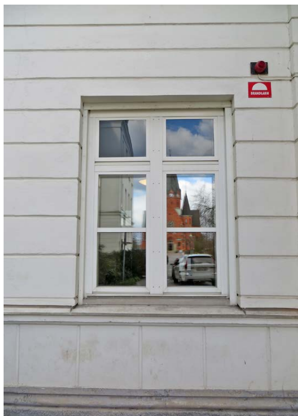
Exempel på fönster i hus 3.
