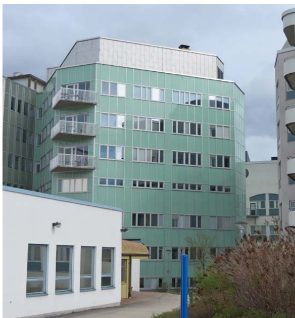
Hus 1 från söder.
