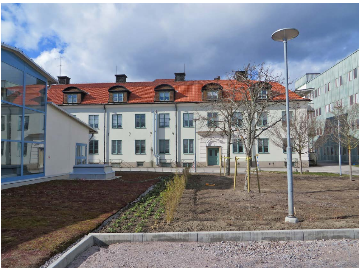
Hus 9 från söder.
