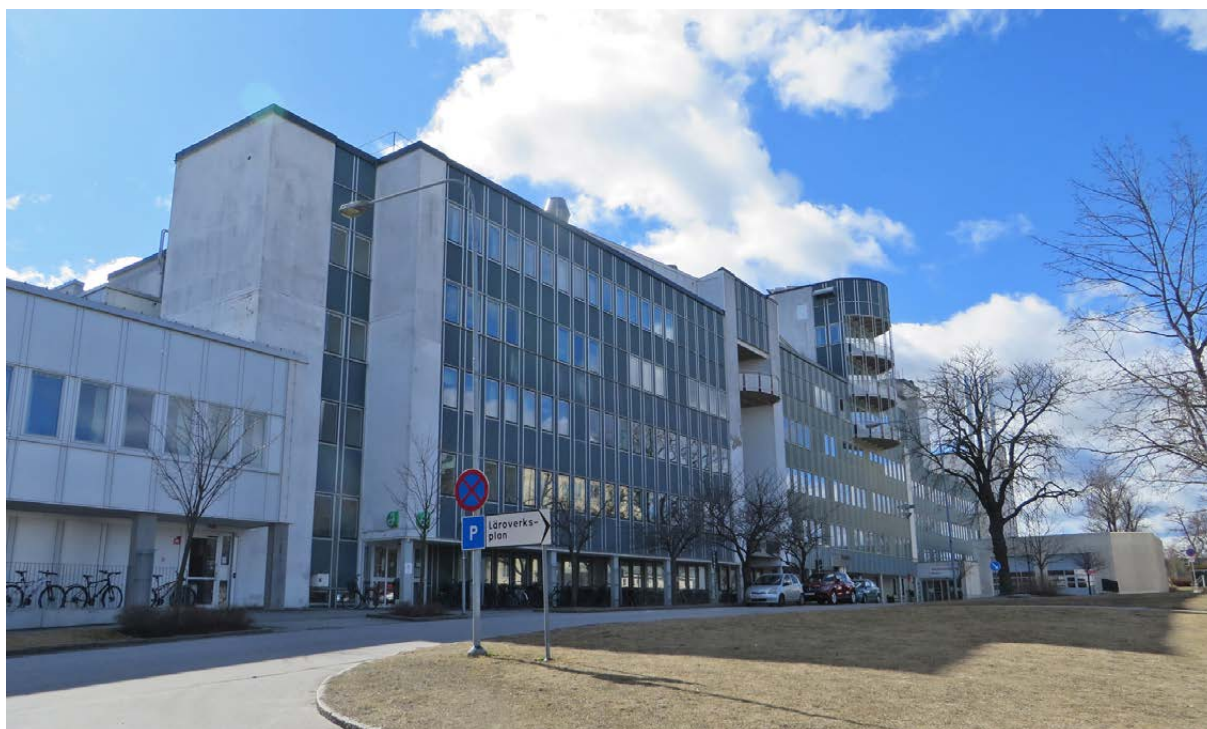
Hus 11 från nordost. Närmast i bilden den senaste tillbyggnaden av huset som gjorts efter 1995.
