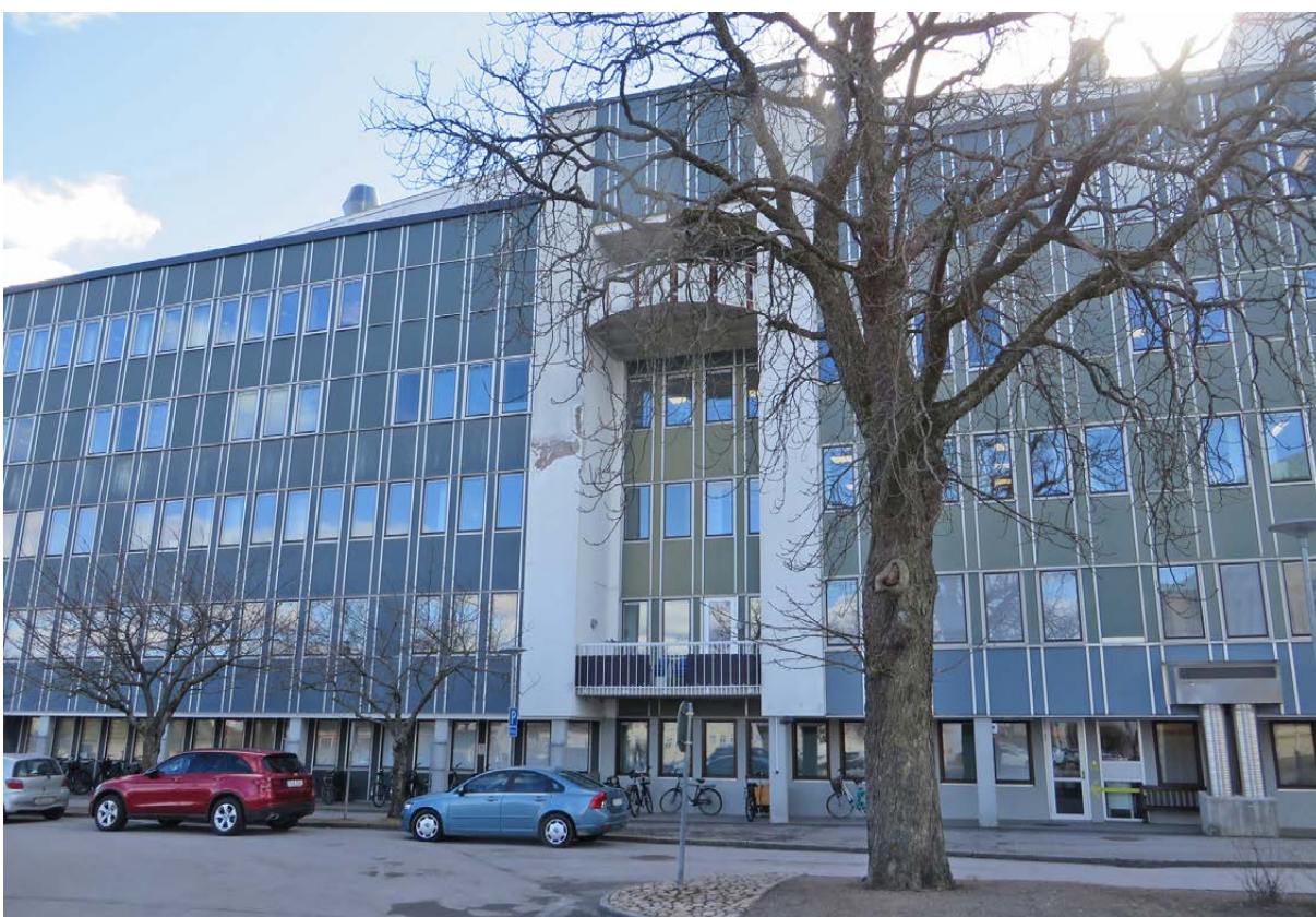
Den långa fasaden mot norr bryts upp av ett markerat parti med balkonger. I bottenvåningen finns en arkad med fyrkantiga pelare. Balkongerna och våningsplanen högst upp tillkom vid ombyggnaden 1995.
