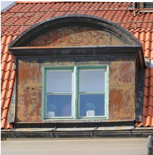
En av de plåtinklädda takkuporna.
