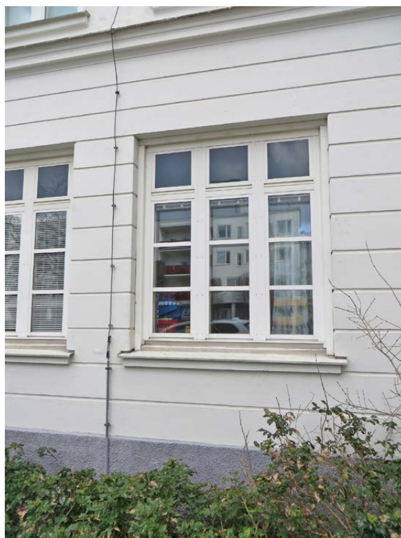
Exempel på fönster i hus 3.
