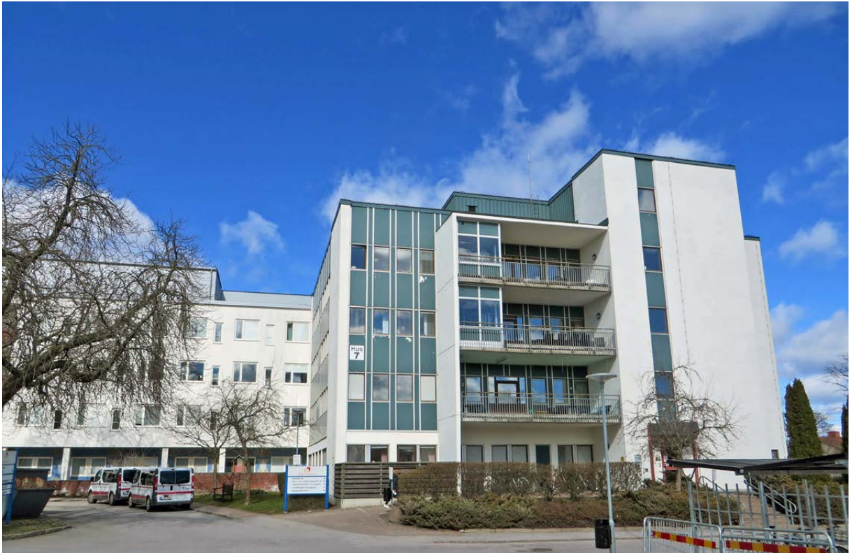
Hus 7 med Folke Lofströms del från 1956 till vänster och Lennart Arfwidssons tillbyggnad från början av 1970-talet till höger.
