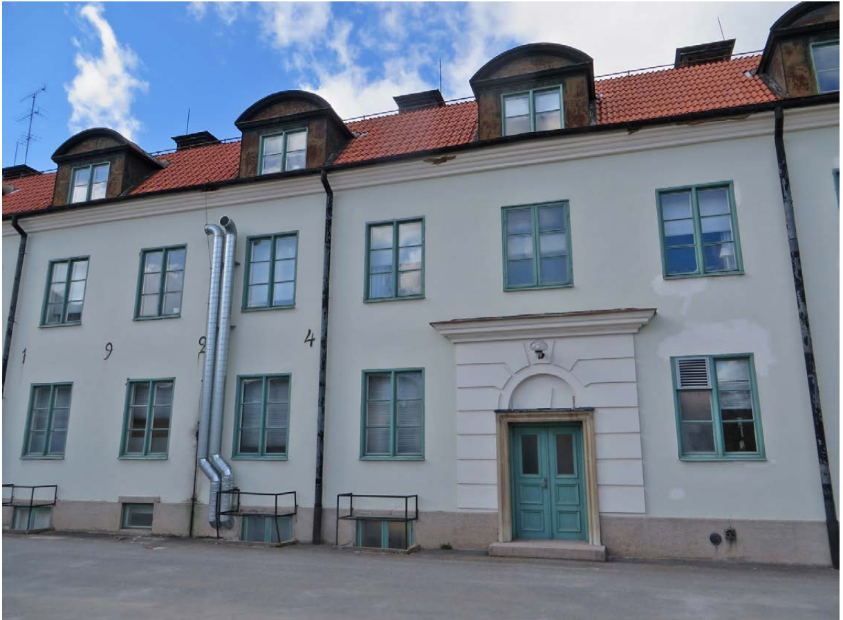
Rusticerad portal med karm av kalksten och spegeldörrar i trä. På fasaden finns ankarslut i form av årtalet 1924 i svart smide.
