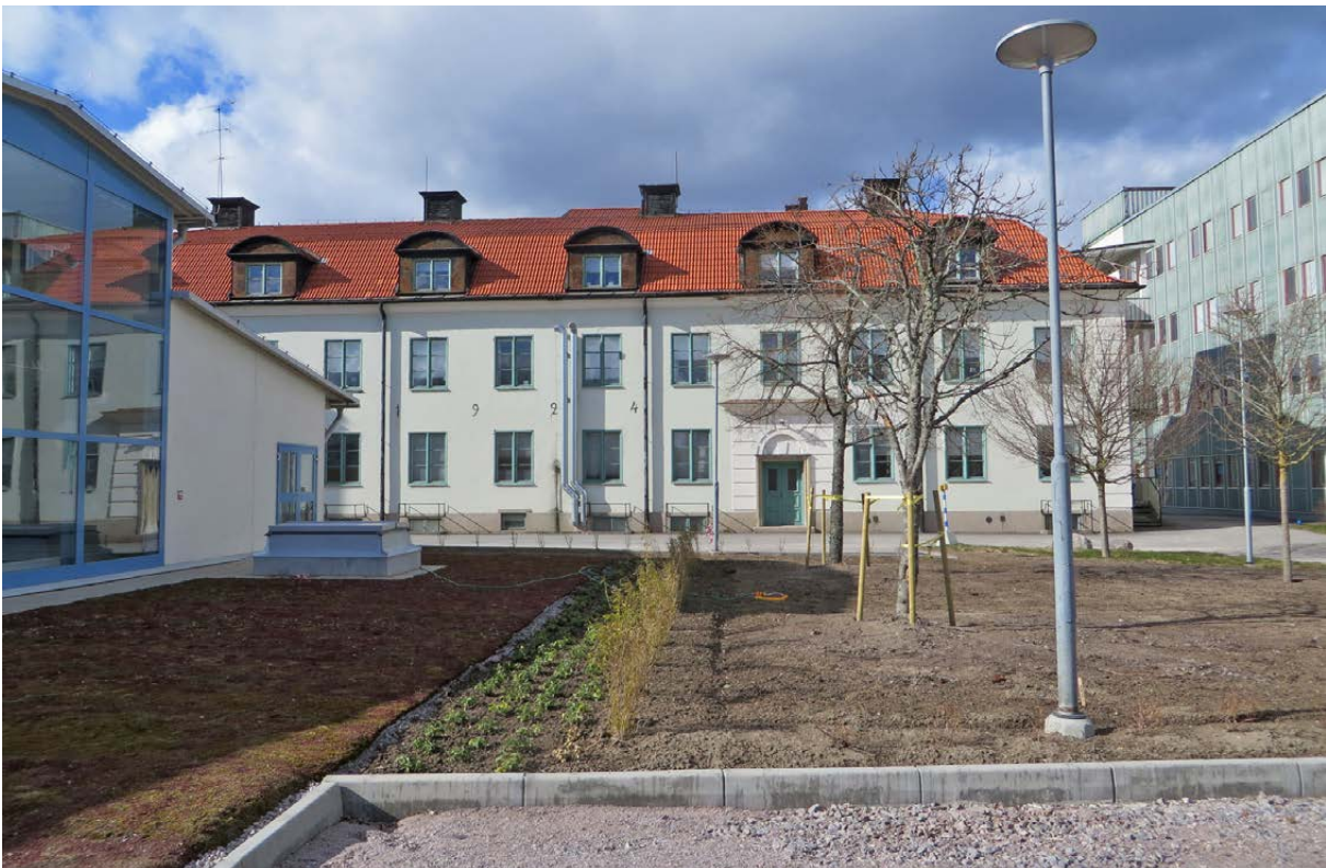
Nyanlagd grönyta söder om hus 9. Inga gångar går genom området vilket indikerar att man ska gå runt miljön men inte vistas i den.
