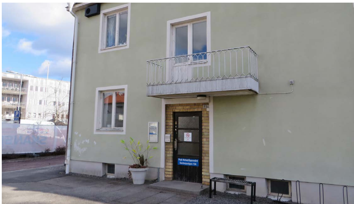
Dörrparti och balkong.
