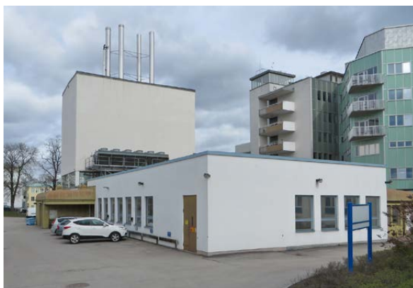
Hus 4 från söder.
