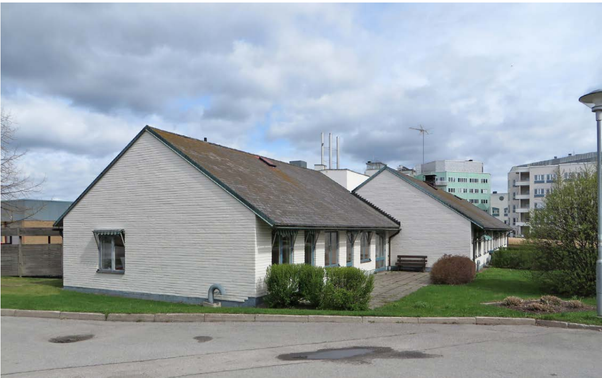
Hus 10 ritat av Folke Lofström och klart 1962. Byggnaden användes av psykiatri. Huset revs 2021.
