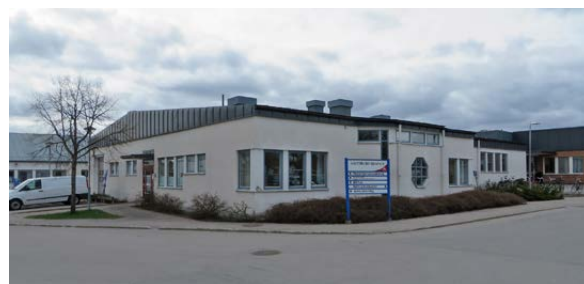
Hus 5 från nordost.
