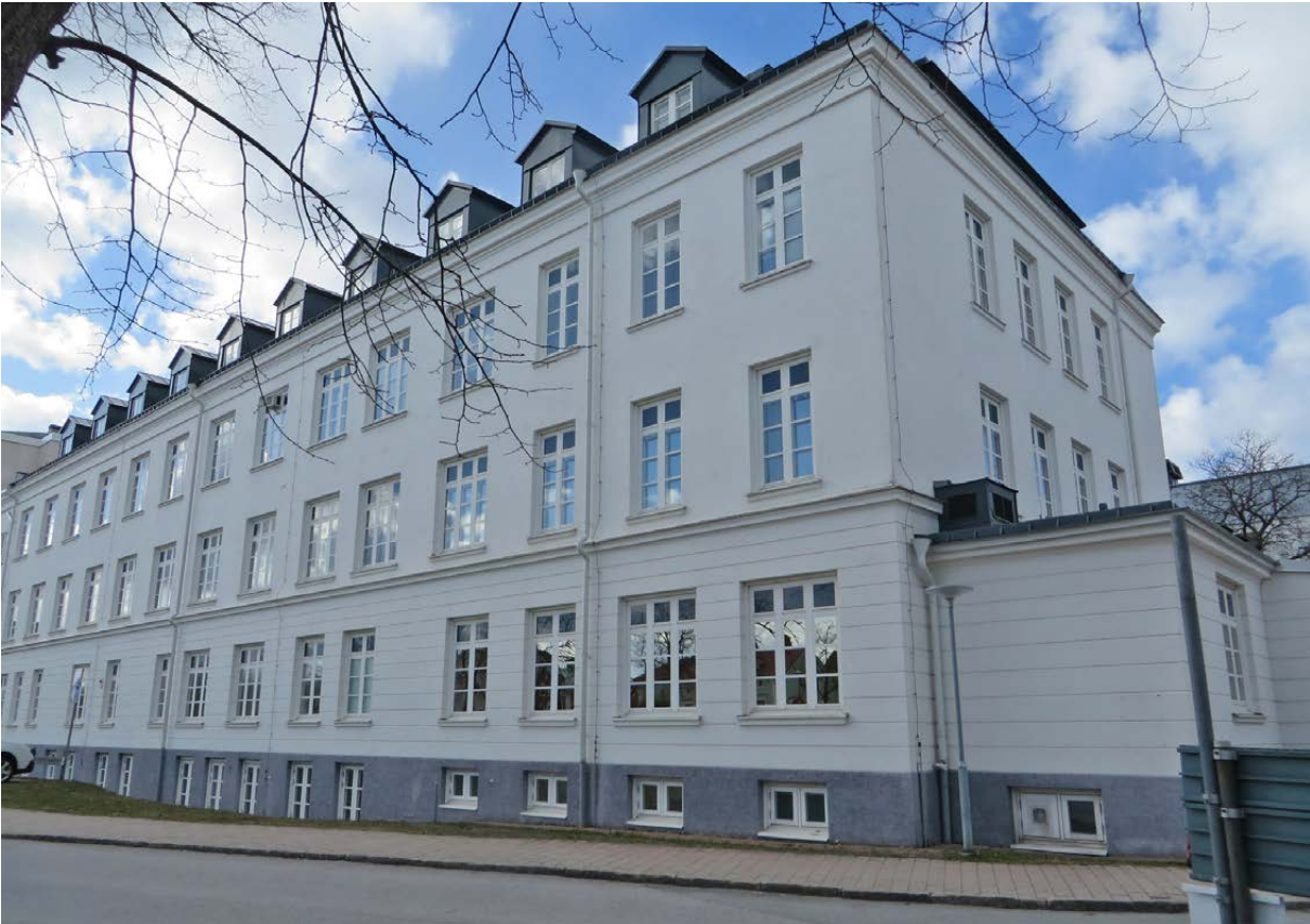
Hus 3 från sydost.
