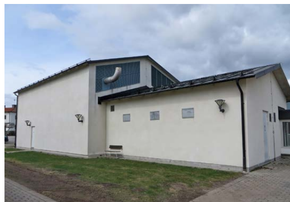
Hus 8 från söder
