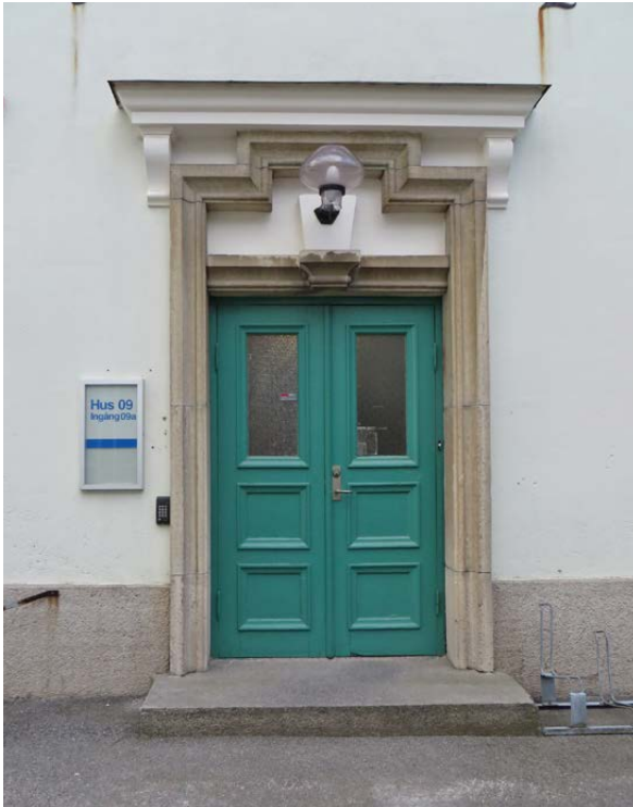
Dörr med omfattning mot norr.
