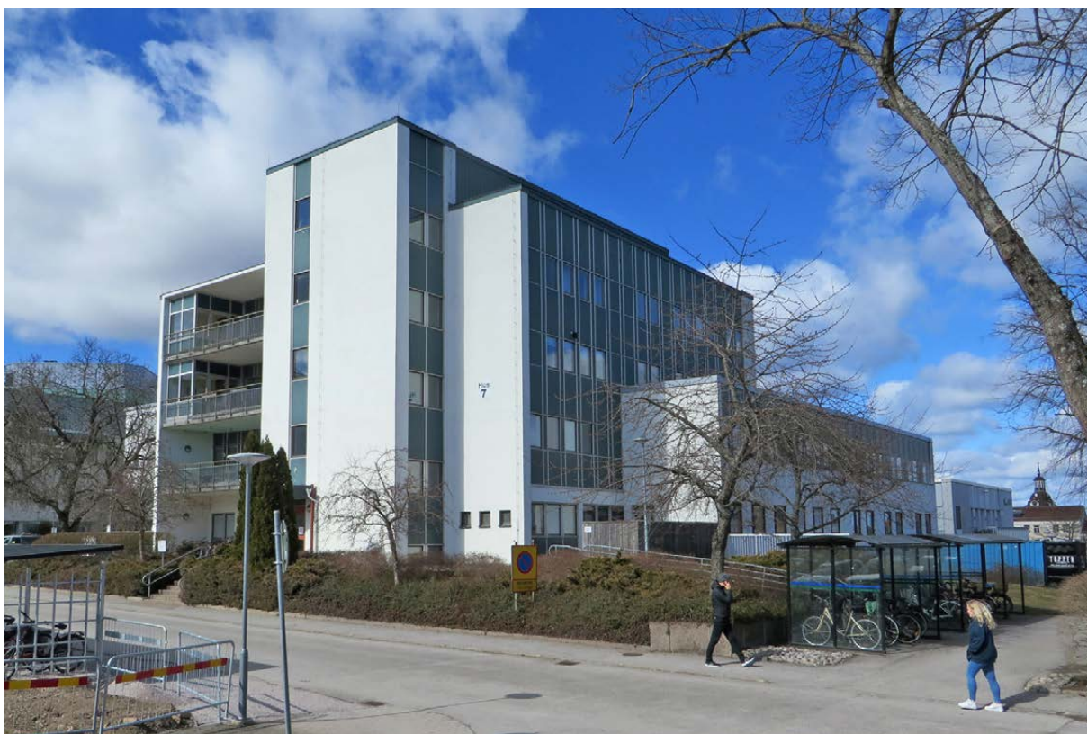
Hus 7 från sydost.
