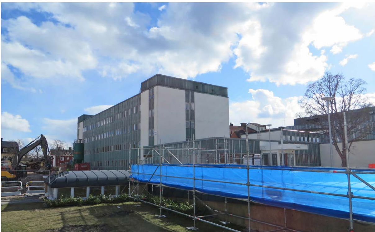
Mitt i bilden syns ett av ljusinsläppen till kulvertsystemet som ritades av Lennart Arfwidsson.
