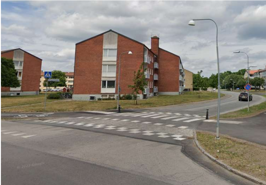
Bild 1. Exempel på upphöjd genomgående gång- och cykelväg i korsning. Även försedd med förstärkt belysning och taktill information.
