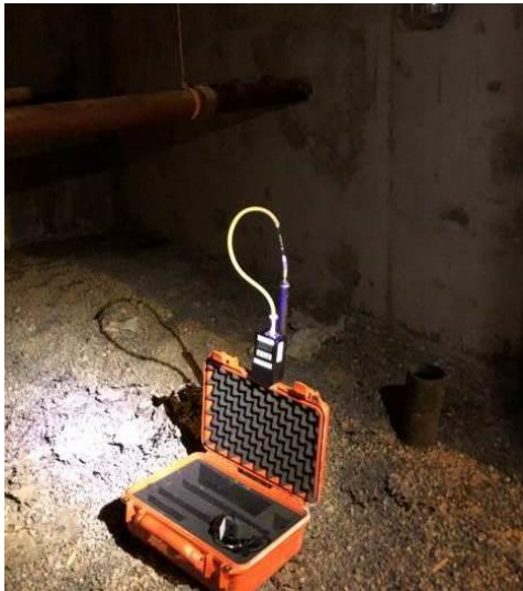
Porgasmätning vid N (underkulvert)
