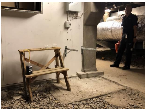
Porgasmätning vid O (underkulvert)
