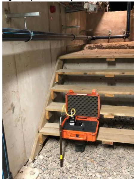
Porgasmätning vid P (underkulvert)
