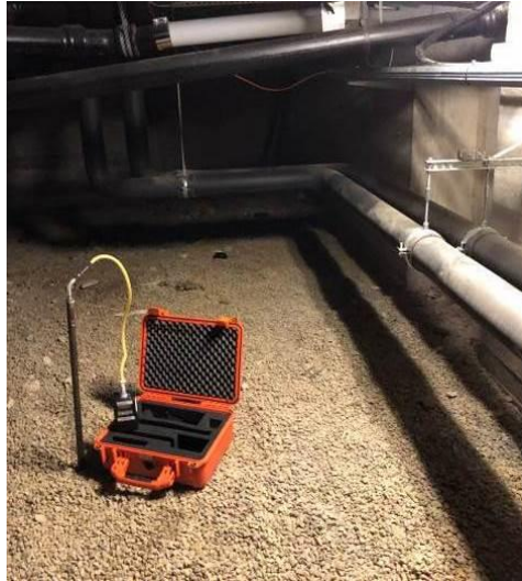
Porgasmätning vid L (underkulvert)
