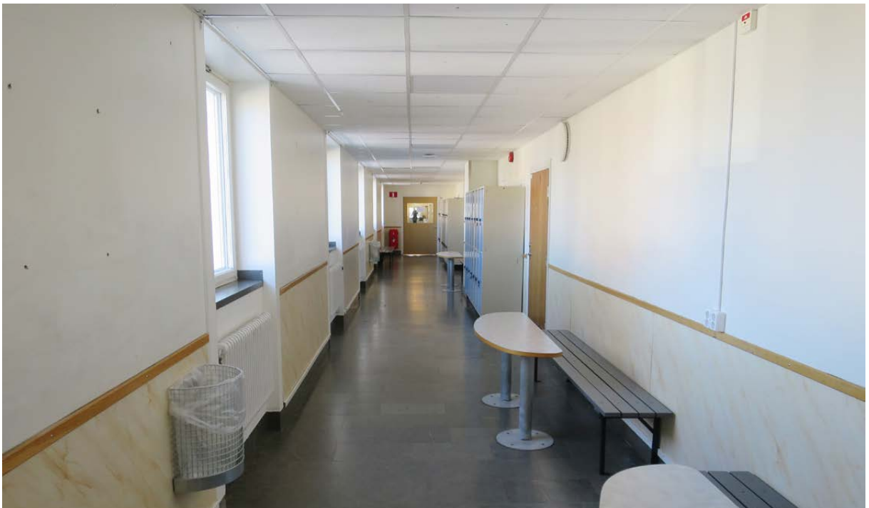
De långa korridorerna mot Kvarngatan, till vänster i bild, och dörrarna mot klassrummen in mot skolgården, till höger i bild, utmärker byggnadens planlösning. Kalkstensgolvet, fönsterbänkarna av kalksten och flänsradatorerna är tidstypiska för 1950-talet.
