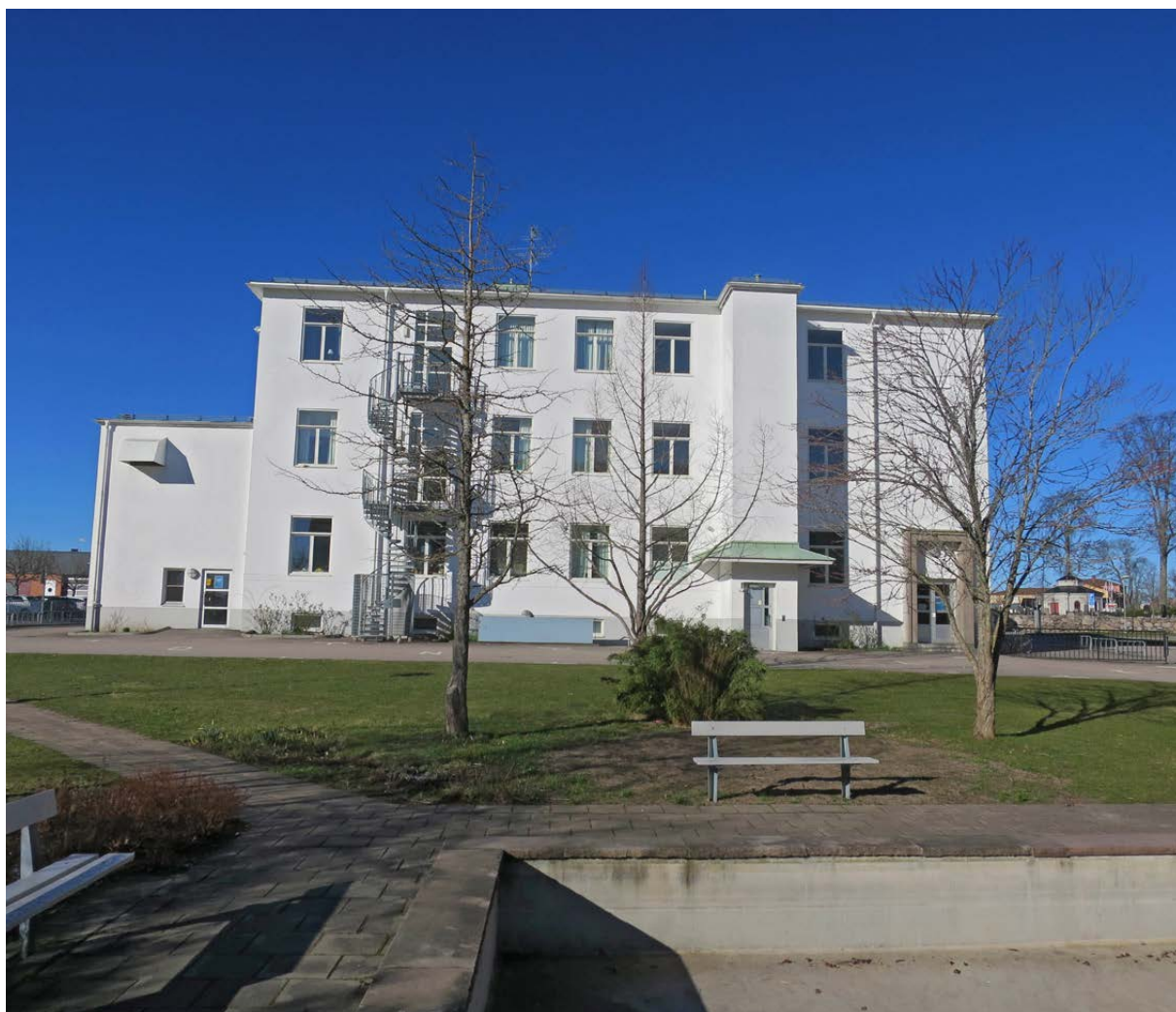
Läroverksbyggnaden från 1936 från öster.
