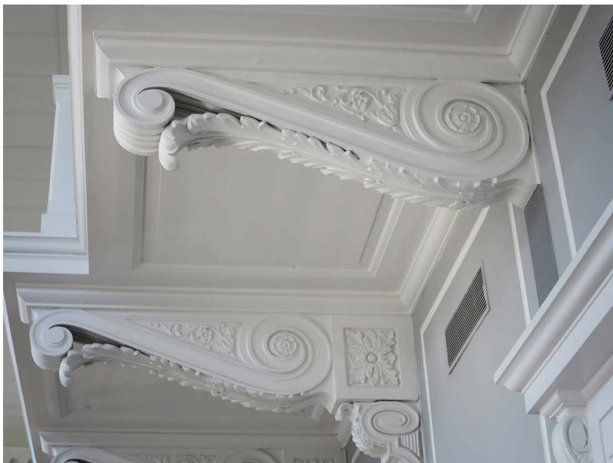
Läktaren bärs upp av kraftiga, rikligt dekorerade konsoler.
