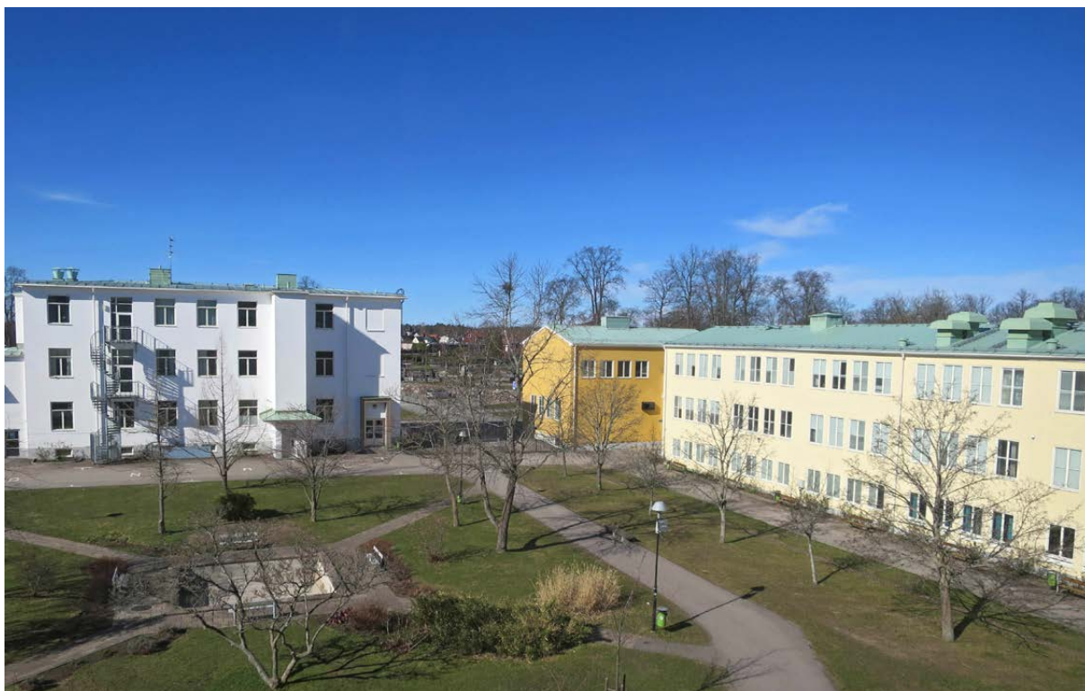
Vy över skolområdet mot öster med byggnaden från 1936 till vänster och byggnaden från 1950 till höger.
