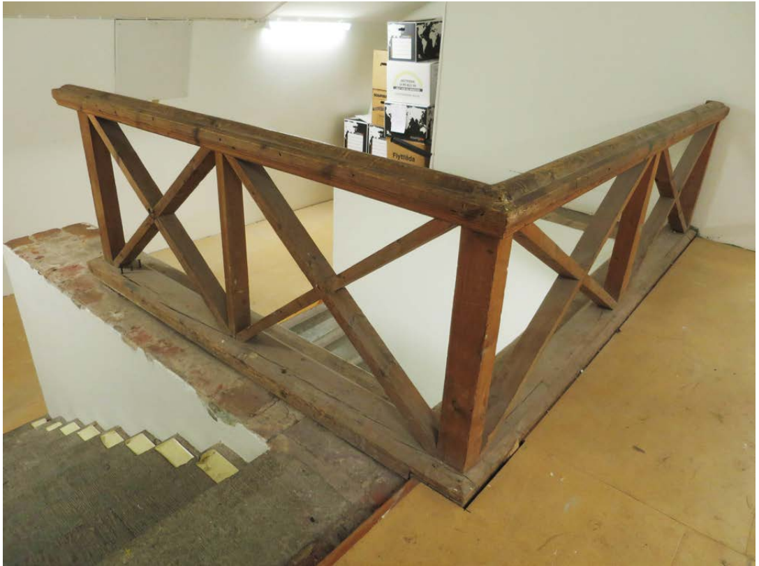
Trapphusets avslutning på vinden med träräcke från 1870-talet.
