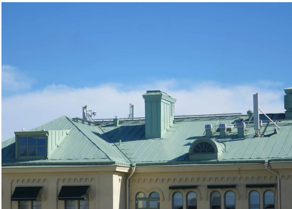
Delar av taket mot söder.
