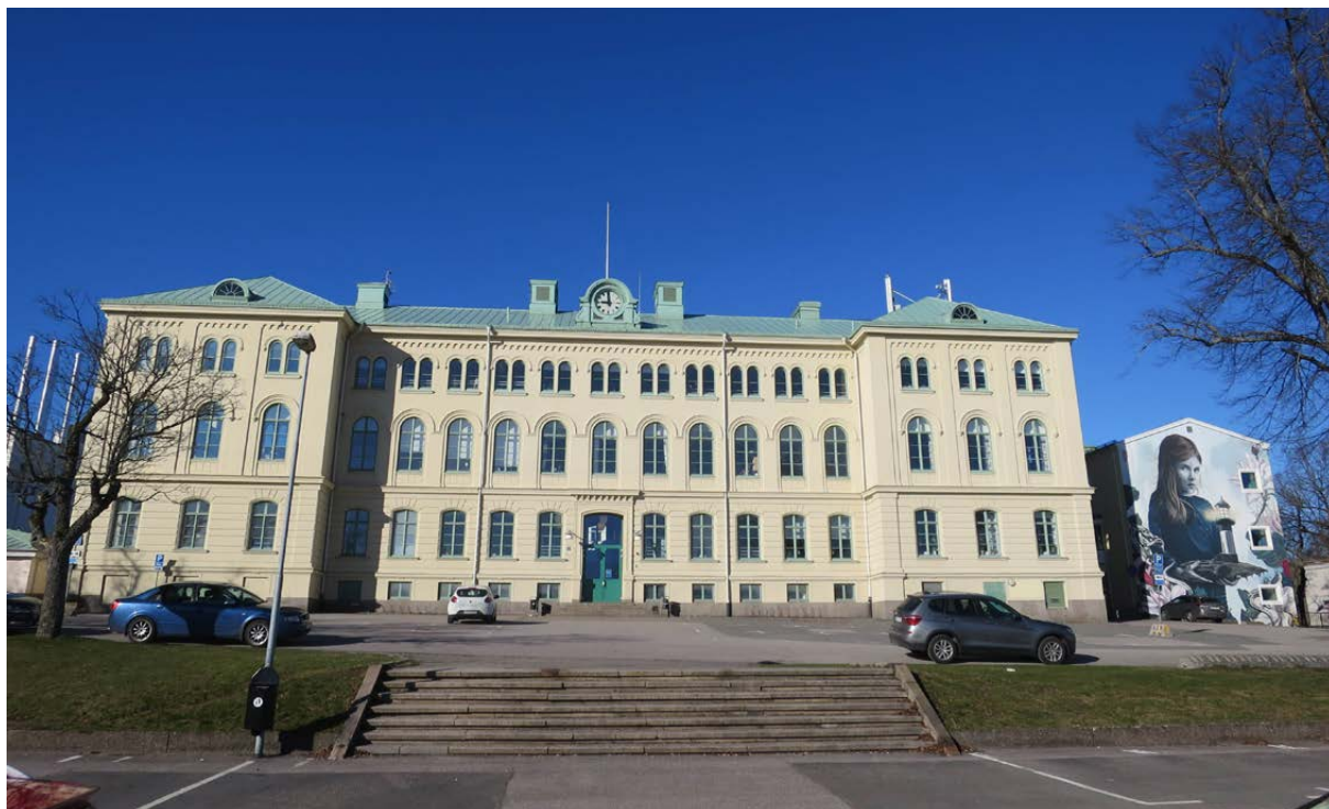
Gamla läroverket i Västervik byggt 1870. Fasad från öster.
