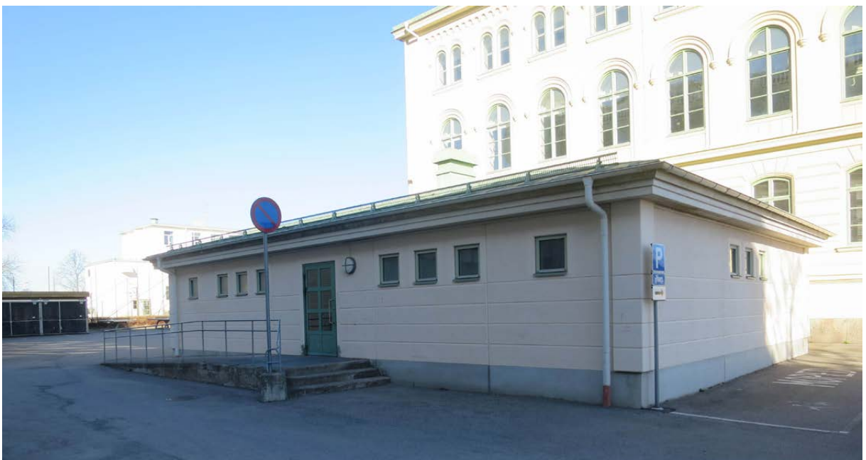
Tillbyggnaden mot söder som tillkom 2001 och rymmer gymnastiksalens omklädningsrum.
