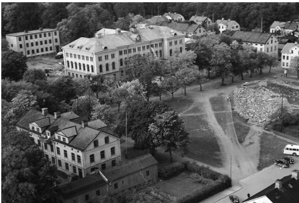
Foto från tidigt 1950-tal. Den stora byggnaden i bildens överkant är läroverksbyggnaden från 1870 och bakom den byggnaden från 1936. Man kan också se taket till 1950-talets läroverksbyggnad. Byggnadsställningar och rester av byggmaterial vittnar om pågående arbeten i byggnaden från 1870. Nedre läroverksplan verkar ha fungerat som någon form av upplag under byggperioden.
