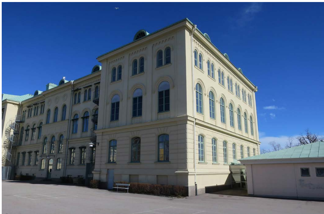
Fasaden mot söder. De stickbågiga fönstren i södra fasaden bottenvåning är troligen original från 1870. De har undgått den inklädning i aluminium som flertalet av skolans fönster har fått. Byggnadskroppen till höger tillkom 2001 och rymmer omklädningsrum och förbindelsegång till gymnastiksalen.
