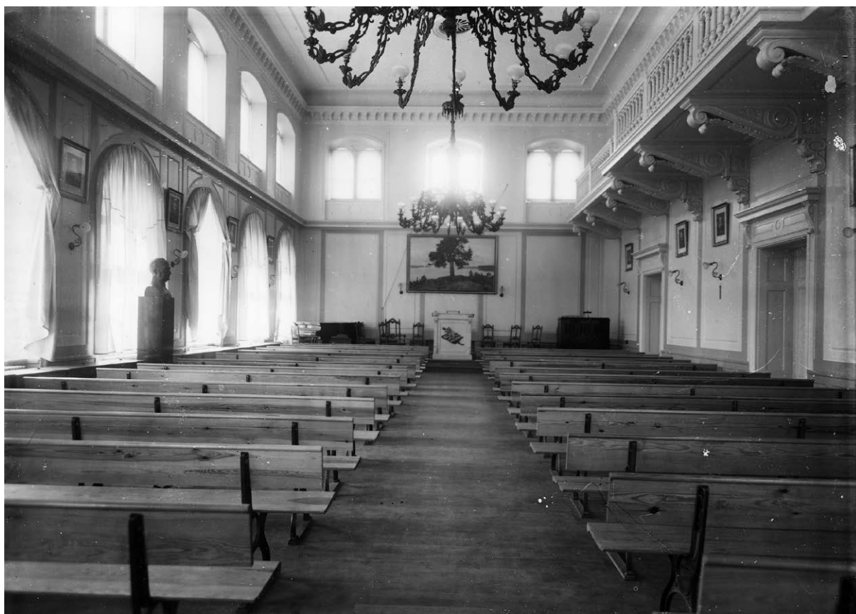
Skolans aula fotograferad någon gång 1900–1930. Väggar, tak och läktare har kvar sitt uttryck än idag. Kvar finns också de stora armaturerna i taket med sina glasglober för gasljus. De omålade furubänkarna, trägolvet, den dekorerade pulpeten och målningen av Gottfrid Kallstenius har däremot försvunnit. Källa: Västerviks museum.
