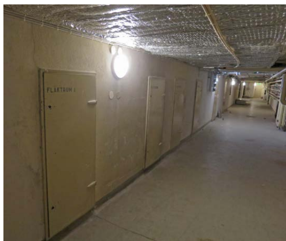
Byggnadens källare rymmer en lång korridor med skyddsrum och tydligt uppmärkta teknikrum.
