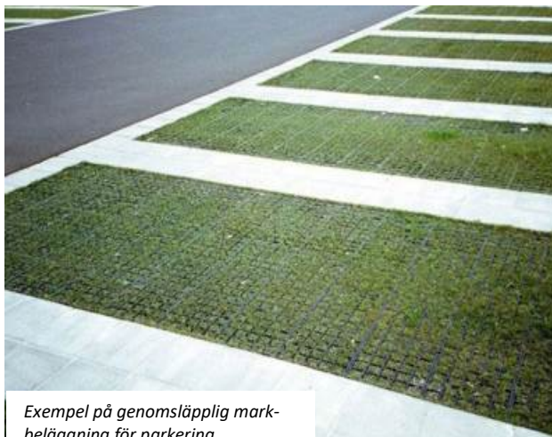
Figur 25 och 26. Bilder som visar utformning av lokal markinfiltration respektive plantering för dagvattenrening
