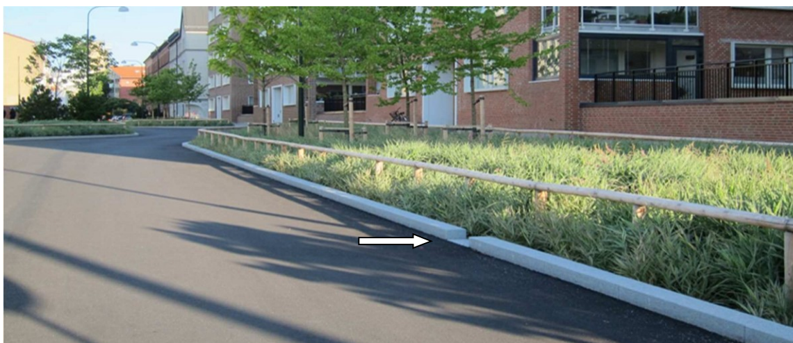
Figur 23. Bild på regnbädd från Monbijougatan i Malmö. Tillfälliga nedsänkningar i kantstenen (se pilen) fungerar som inlopp där dagvatten tar sig in i regnbädden. Källa: baramineraler.se
