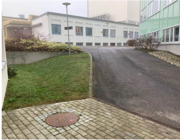
Foto. Sänkan vid Hus 20 mot Hus 04, 01
