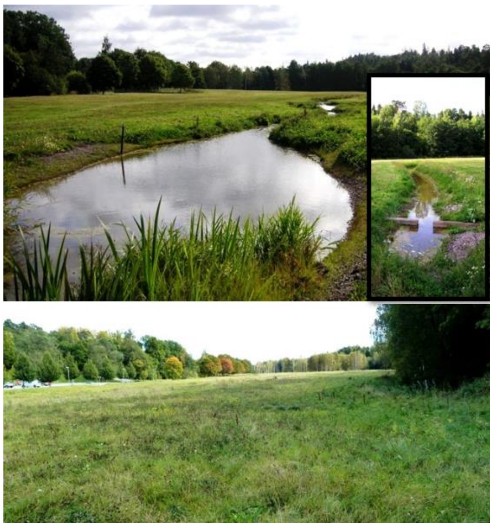
Figur 15. Fotomontage över Laduvikens vattenpark. Överst: Dagvattendamm med vattenspegel som mynnar ut i utjämningsdiken med överfall. Nederst: Översilningsyta i anslutning till vattenparken (vaguiden, 2023).
