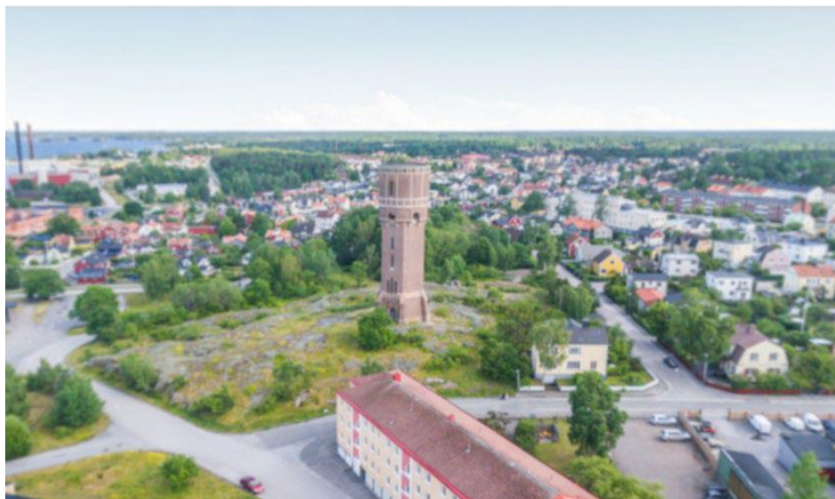
Figur 30: Drönbild på Gamla vattentornet.
