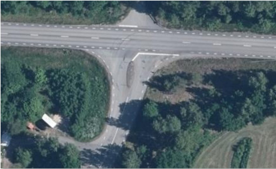
Figur 5. Korsningspunkt mellan väg 40 och 786. (Lantmäteriet, 2022)
