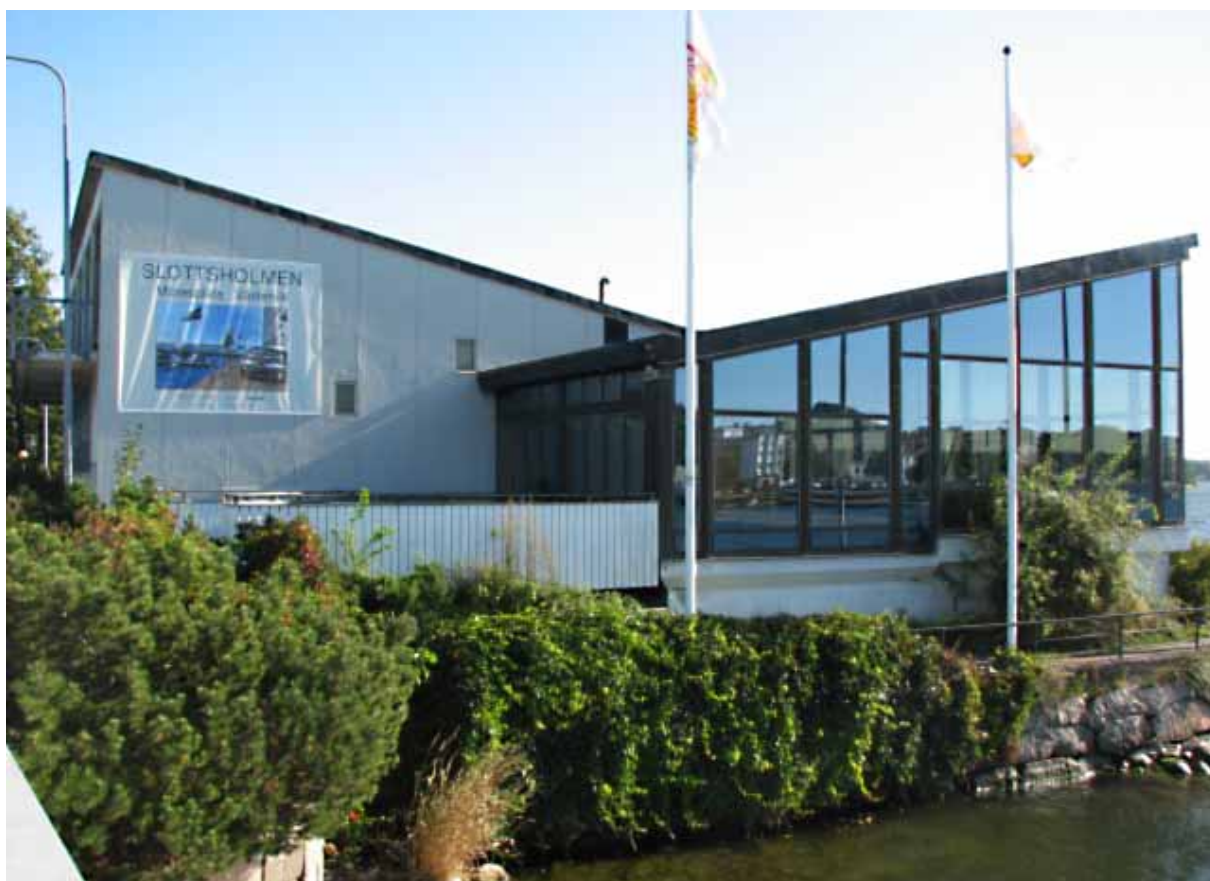
Fig 36. Byggnaden har en speciell gruppering av byggnadsvolymer, vilken blir särskilt tydligt sett från söder.
