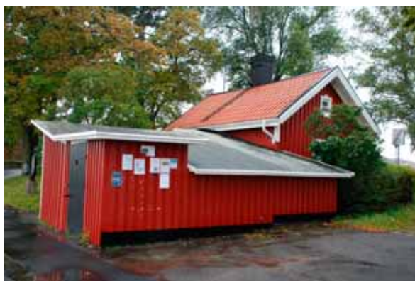
Fig 47. Uthuslängan har en sentida tillbyggnad mot norr.
