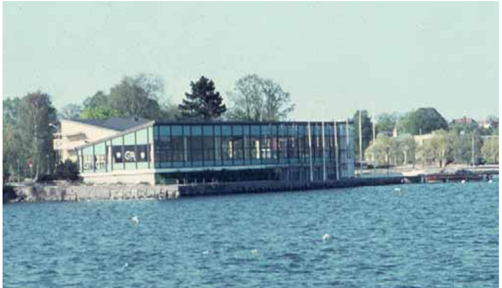
Fig 32. Restaurangbyggnaden år 1971, året efter att de ursprungliga glasfasaderna bytts ut. Foto: nr Västervik55, Kalmar läns museums arkiv.
