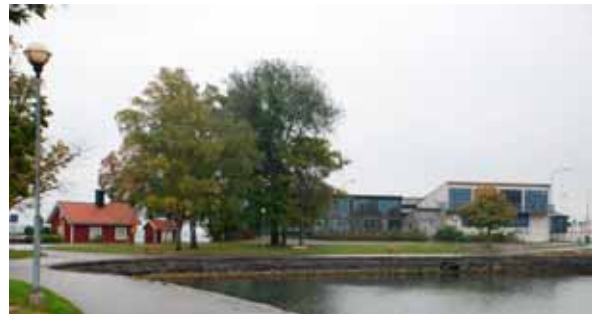
Fig 29. Den sk brovaktarstugan, transformatorbyggnaden och restaurangbyggnaden ses på rad.
