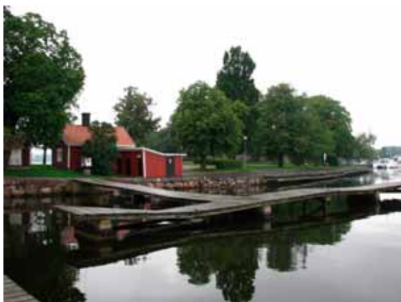
Fig 45. Huset sett från sydost. Bryggkonstruktionen i förgrunden är uppförd på fundament från kallbadhuset.
